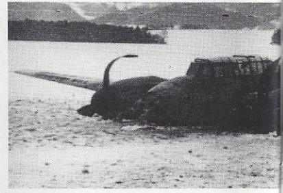
Die Bf 110G-4/B2 kam mit eingezogenem Fahrwerk nach gut 50 m auf einer Wiese bei
