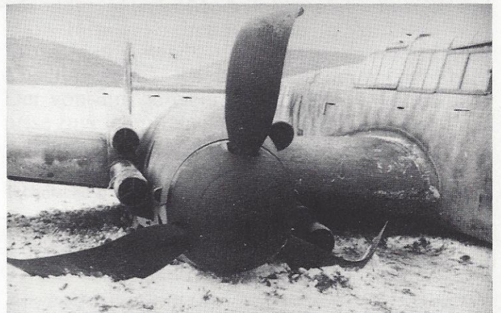
Der rechte Daimler-Benz-Motor mit den für die Nachtjäger typischen Flammenvernichtungsrohren
