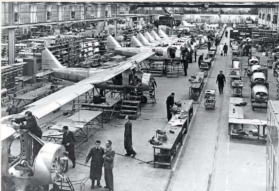
Die erste in Deutschland gefertigte Nachkriegsentwicklung: Serienbau der Do 27 in Oberpfaffenhofen
